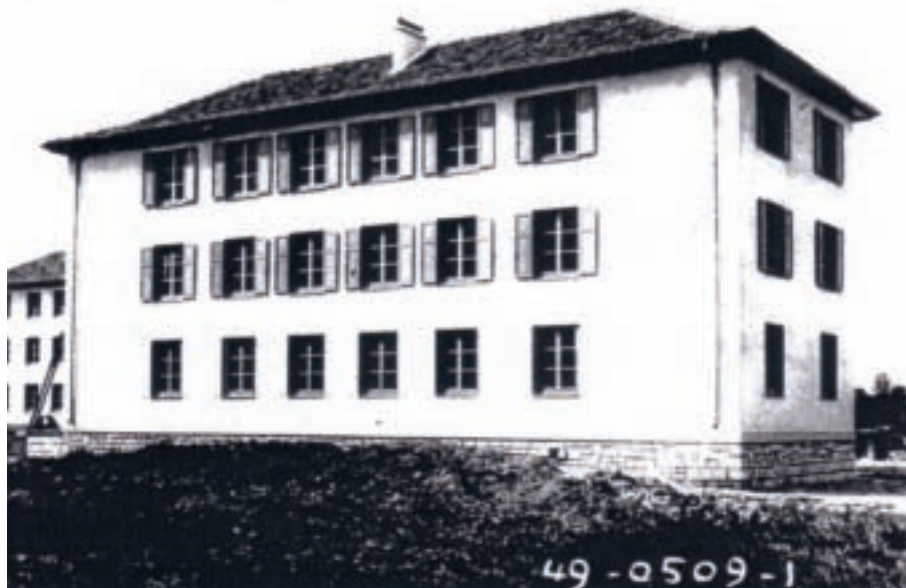
Premier chantier expérimental de la Cogetravoc (source : 1951, MRU, A.N. 771080/34).
