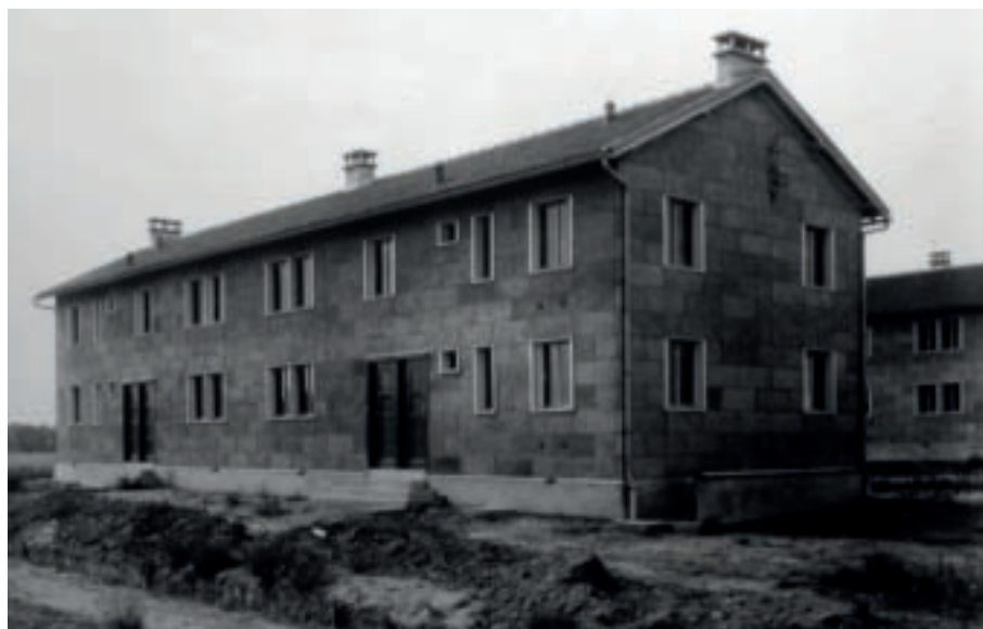
Maison Phénix en construction et achevée sur le chantier d'expériences de Creil (MTPB, n8 hors série, 1950 - AN/CAC/19771125/C3418-11).
