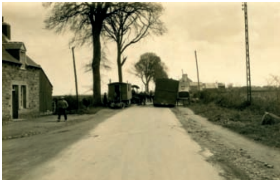
« Les Villages », travaux de voirie, 1936 [AM Saint-Brieuc, 6 Fi 622].
