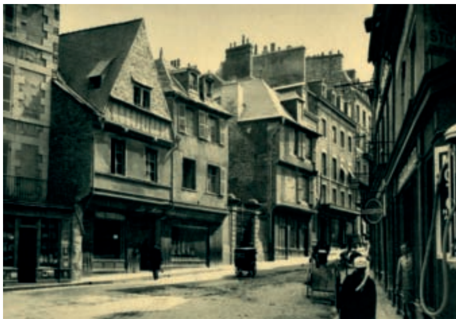
La rue Houvenagle avant les travaux de 1930 [AM Saint-Brieuc, 8 Fi 028]
