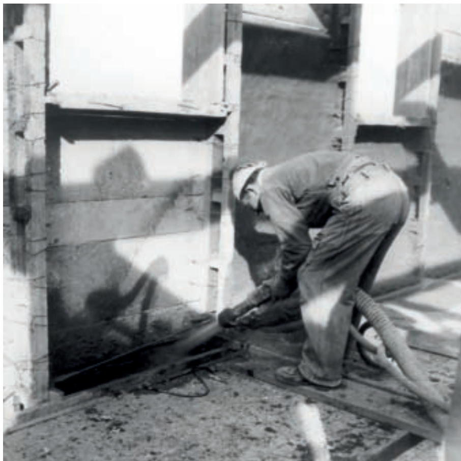
Projection de mortier au canon à ciment sur l'enveloppe extérieur d'un pavillon Inotro à la cité des Ruisselets, à Beauvais (Archives CSTB).
