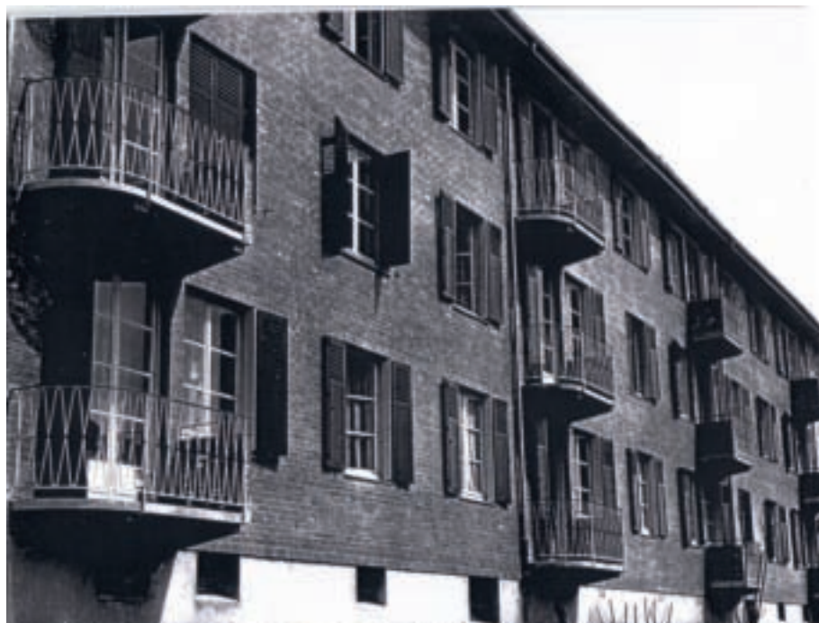
Second chantier expérimental de la Cogetravoc (1951, MRU, A.N. 771080/34)
