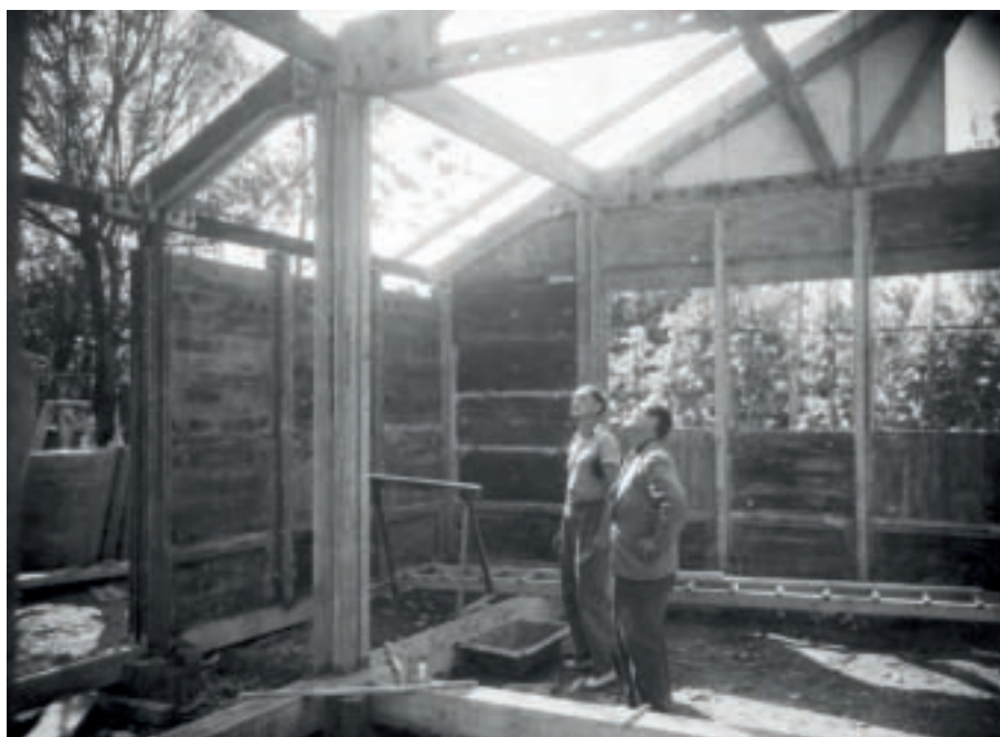
Pavillon JEEP en construction sur le chantier d'expériences d'Argenteuil (AN/CAC/19850378/C7790).
