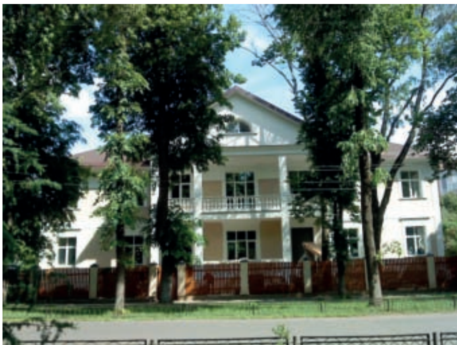
Maison réhabilitée par un Nouveau Russe, surnommée par les habitants le Palais de la Culture, chantier en cours, Sokol, juin 2009
