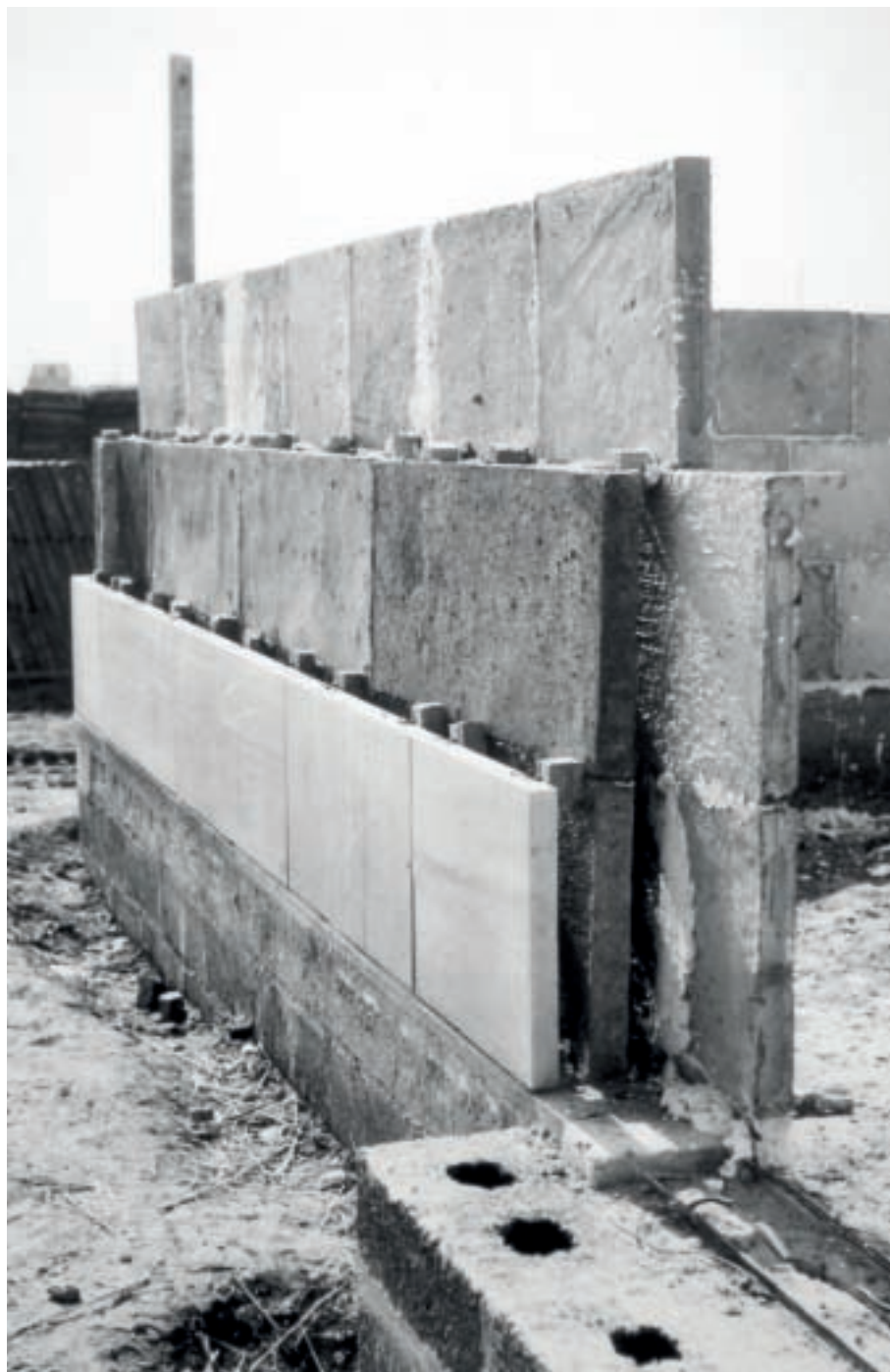
Constitution d'un mur triple couche réalisé par le procédé Le Village Français (Archives CSTB).
