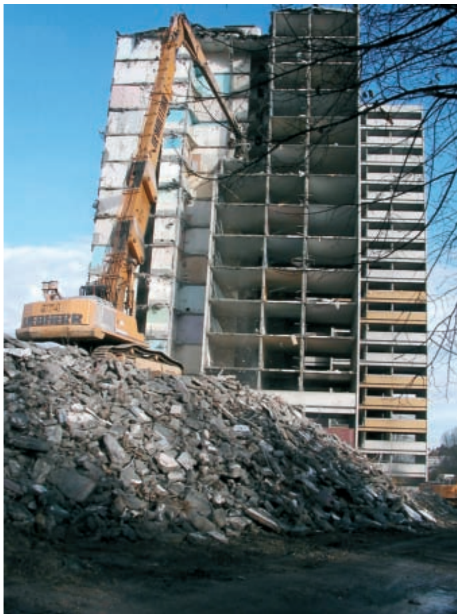
Déconstructioin d'une tour dans le cadre d'un projet ANRU, Corbeil-Essonnes les Tarterêts [photographie H.Guillaume]
