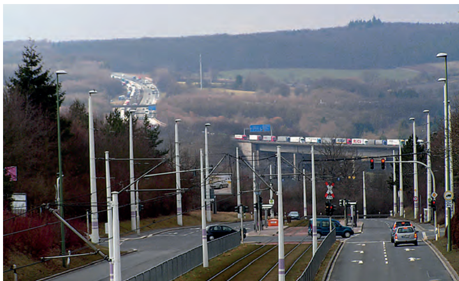
Doc. 1 : Würzburg, vue vers le sud. La vallée du Main est à gauche de l'image. Les rubans de la route et du tramway relient le centre de Würzburg à Heuchelhof (sur le plateau en haut et à gauche, invisible ici). [Photo PB, avril 2010].
