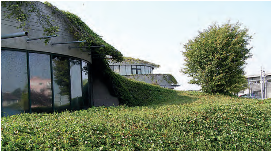
Doc. 6 : un bâtiment administratif (direction du travail et de l'emploi) construit par Jean Nouvel [Photo PB, juin 2010].
