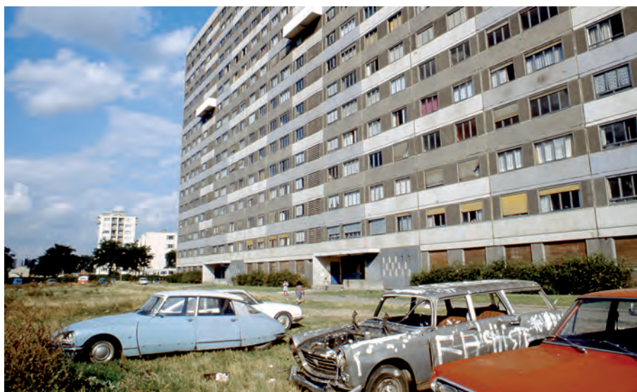
La cité et ses abords à l'abandon en 1981, peu avant le début de la première réhabilitation. Cliché issu d'un reportage photographique de la Direction régionale de l'Équipement d'Île-de-France mené en septembre 1981.
