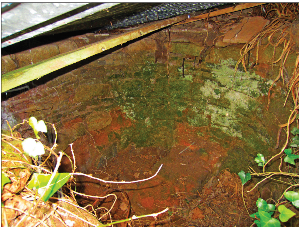
Fig. 9 : Vue actuelle de l'intérieur d'un four.
