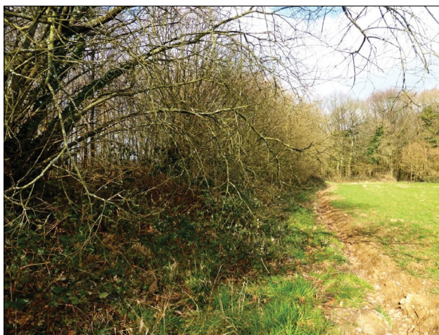
Fig. 4 : Talus arboré construit sur la voie qui forme banquette.
