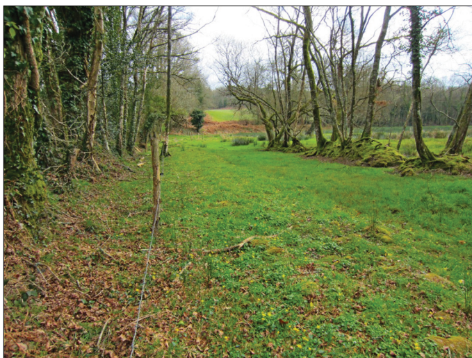
Fig. 17 : La chaussée bombée à Pont-Davy.
