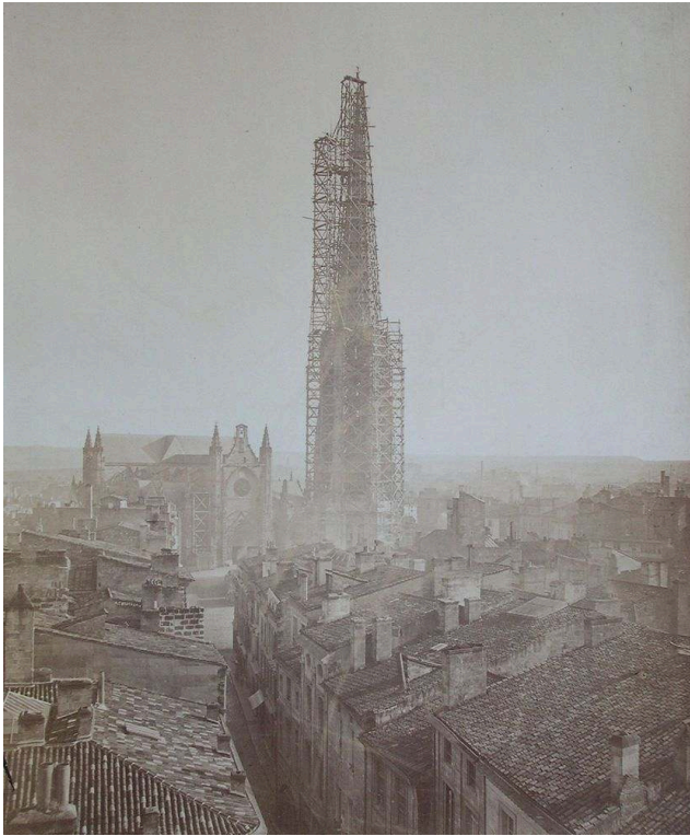
Fig. 4 : Alphonse Terpereau, Échafaudage de la tour Saint-Michel , 1865, tirage sur papier albuminé, 46,6 x 37,9 cm, Bordeaux, bibliothèque municipale, XVI 51-4.
